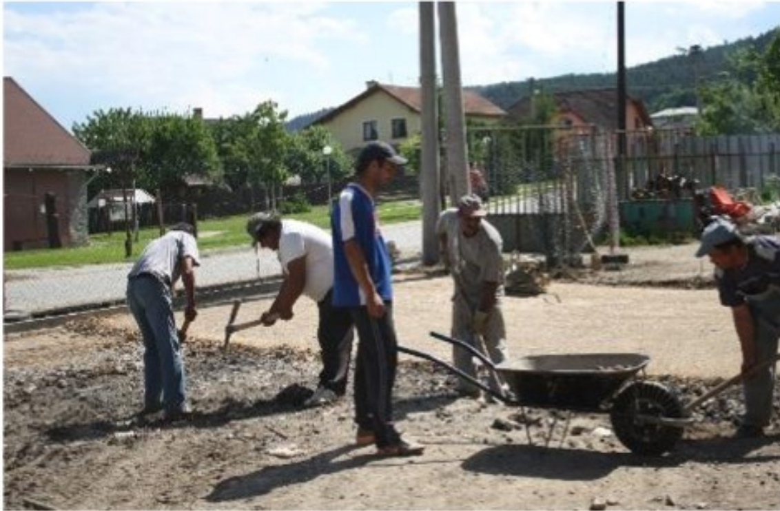
Bürger von Spišský Hrhov bei Bauarbeiten
