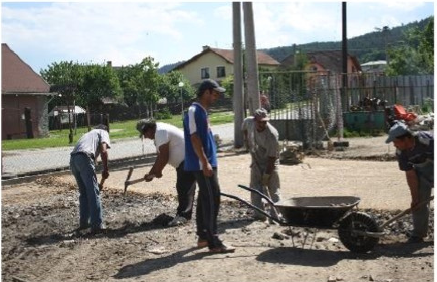
Obyvatelia Spišského Hrhova pri stavebných prácach
